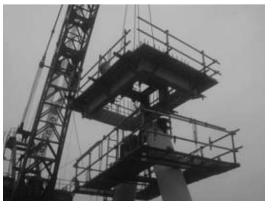
図-4 ハーフプレキャスト架設状況
