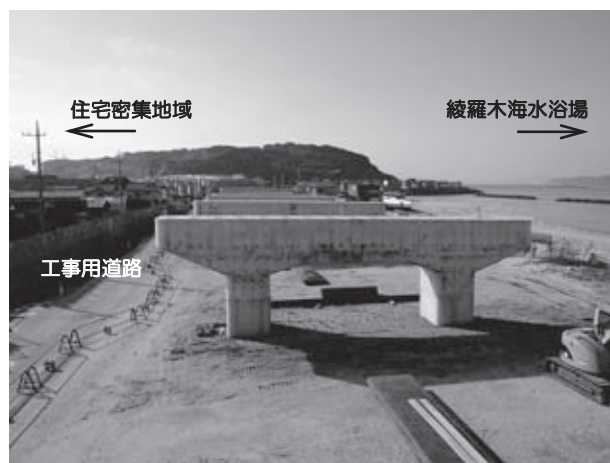
図-1 着工前現場状況
