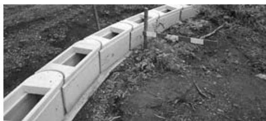
図-5 現場施工状況写真
