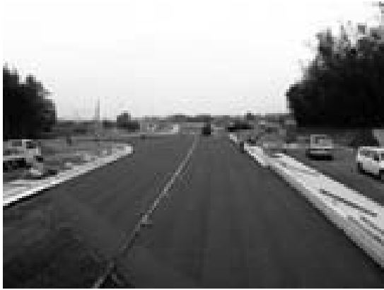
図-3 クラック抑制シート施工状況
