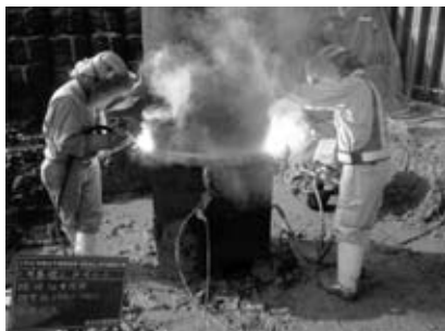
図-14 継ぎ溶接作業状況
