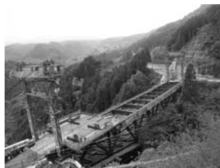
図-5 ケーブルクレーン架設
