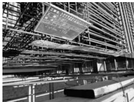
図-4 ハイパーネット設置状況（剛結部側面）
