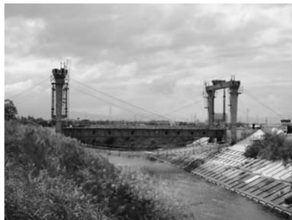
図-2 門構組立全景
