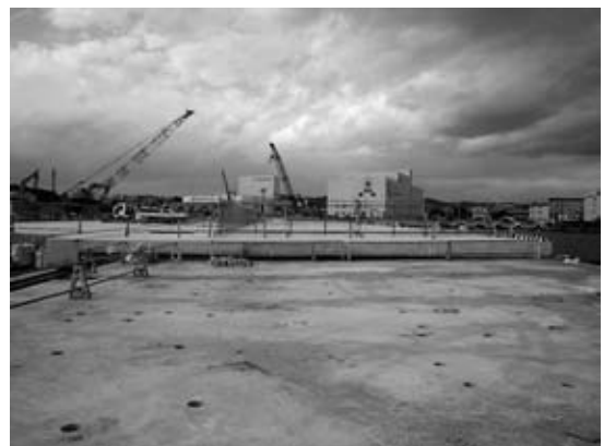
図-4 現在の現場状況
