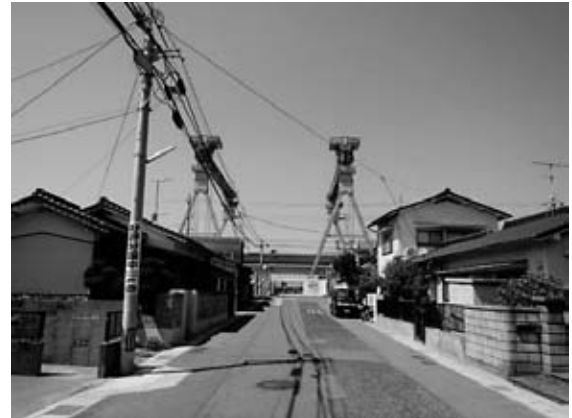
図-3 住宅密集地域での架設
