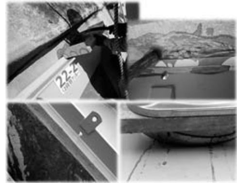
図-11 設置面の空隙処理
