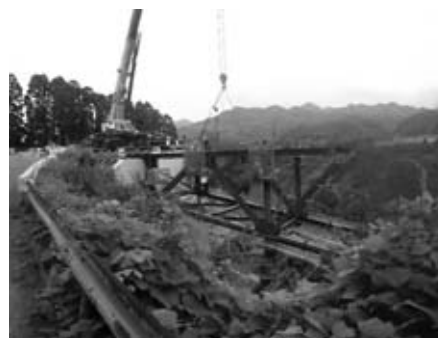
図-4 トラッククレーン架設
