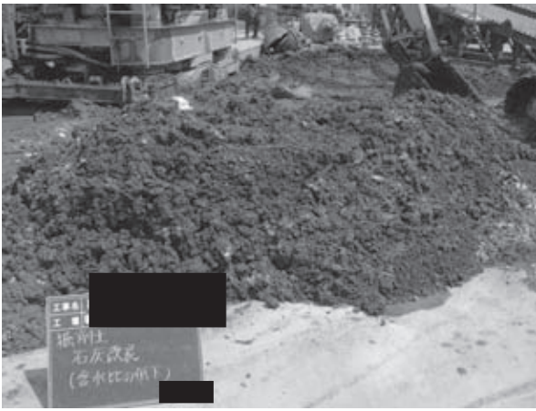
図-3 掘削土の石灰改良
