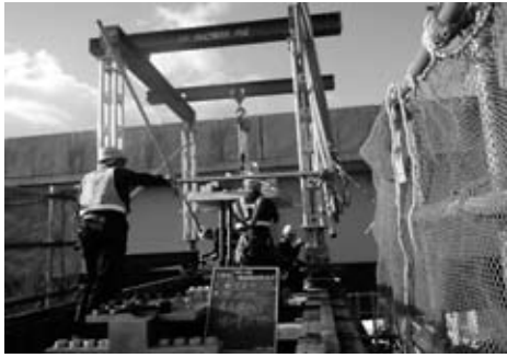
図-2 支承の移動設備
