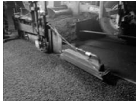
図-4 ジョイントヒータの使用
