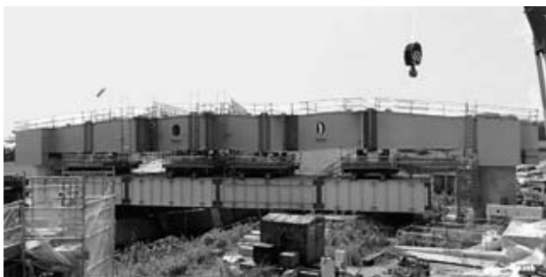
図-4 横梁架設完了
