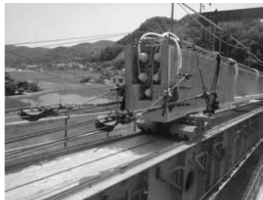
図-5 主桁引き出し状況
