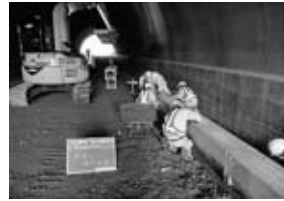
図-4 側溝施工状況及び養生状況
