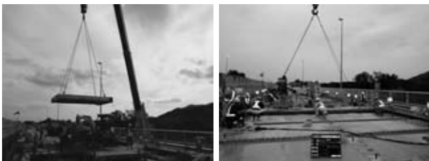
図-11 床版撤去・新設状況
