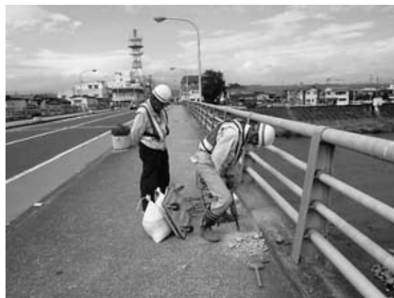
図-2 下流方歩道試掘状況
