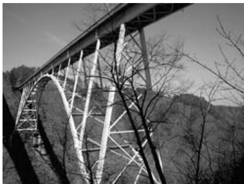
図-1 槇木沢橋全景(補修前)
