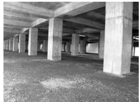
図-2 人工島1階部分 着手前（狭小な状況）
