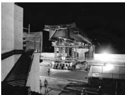
図-2 多軸台車による送り出し架設
