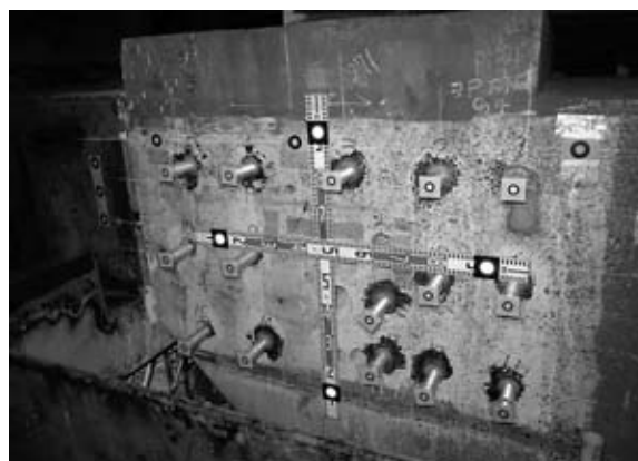
図-3 アンカーボルト写真計測
