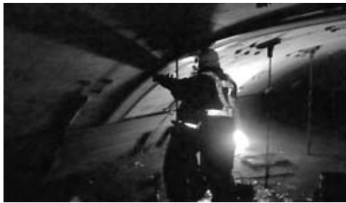
図-2 線導水設置状況
