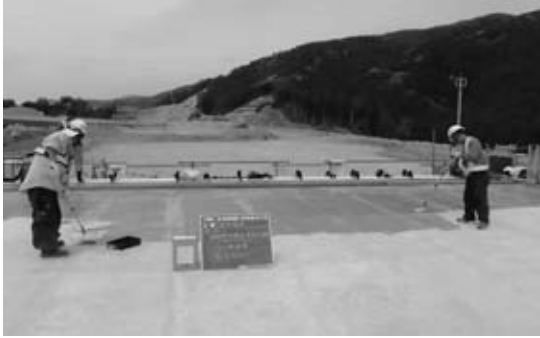
図-7 クラックセイバー塗布状況
