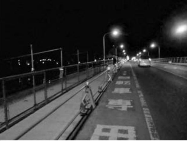
図-6 夜間歩道の安全対策
