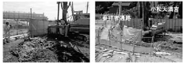
図-8 飛散防止対策状況
