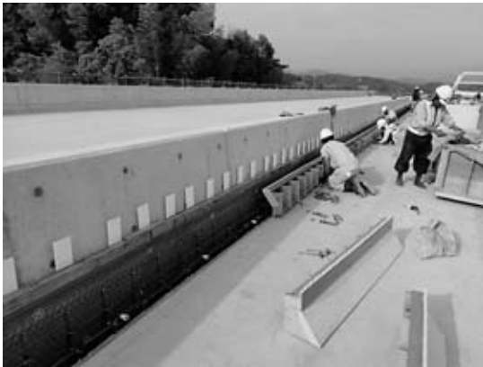
図-4 下り線地覆外型枠組立状況 (奥側が上り線・中央分離帯完了)
