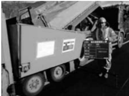
図-3 アスファルトフィニッシャの保温対策
