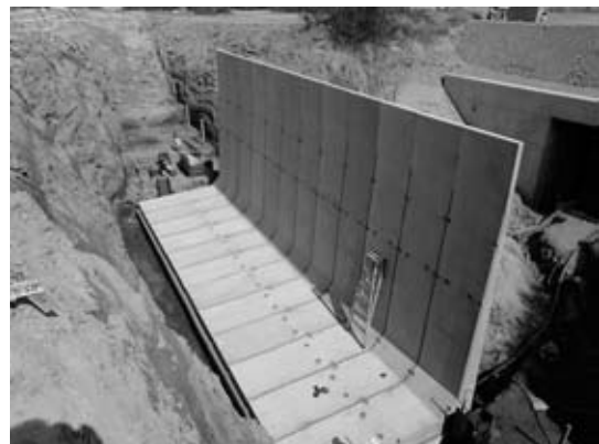
図-4 L型据付完了
