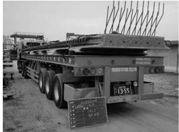
図-3 PC床版の出荷状況
