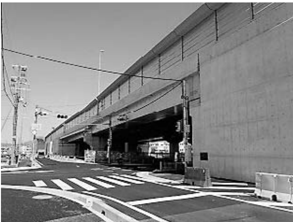
図-1 Bランプ橋（竣工時）
