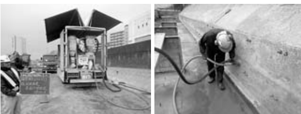
図-5 サーブラスト工法
