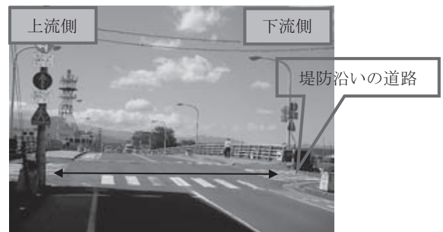
図-1 施工前全景（起点方より）
