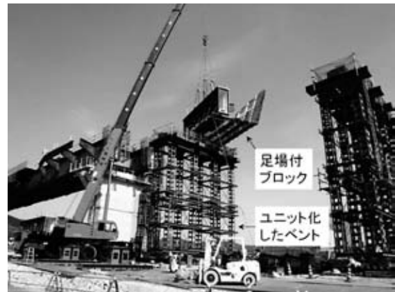
図-2 設置したベントと足場付主桁ブロック
