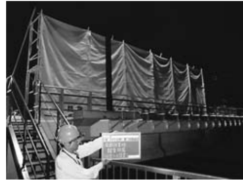
図-2 防音シート設置状況写真
