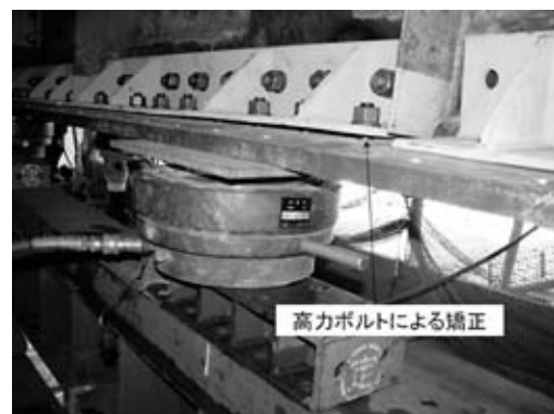
図-6 高力ボルト締め上げによるプレス矯正
