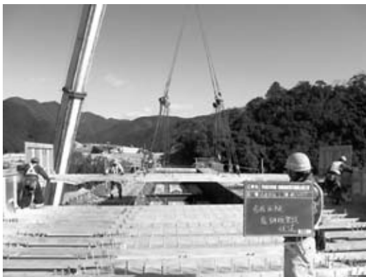
図-9 合成床版パネルの架設状況
