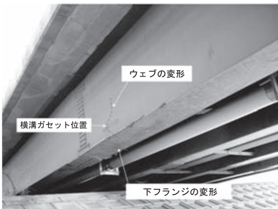
図-2 桁下フランジの変形
