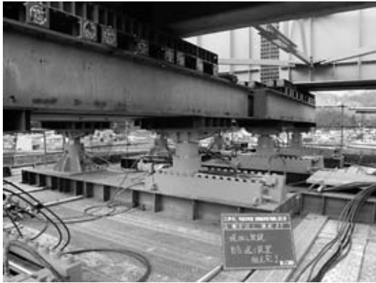
図-8 「送り装置」の組立て状況
