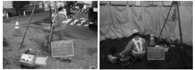
図-8 センサー挿入 図-9 孔曲がり測定
