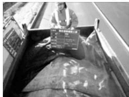
図-1 保温シート（麻布＋断熱シート）
