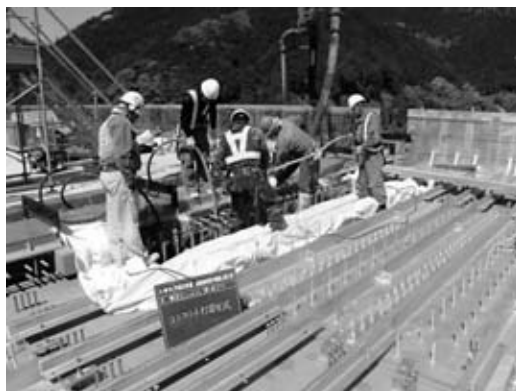
図-6 巻立てコンクリート打設状況
