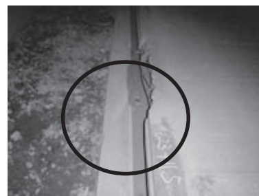
図-1 SPによる側溝の破損例
