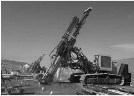
図-3 地盤改良工 斜め削孔状況
