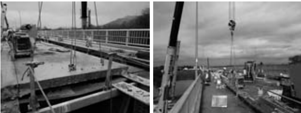
図-6 床版2次切断・吊上げ（床版・地覆）
