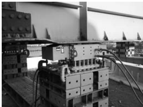
図-4 シンクロジャッキ設備
