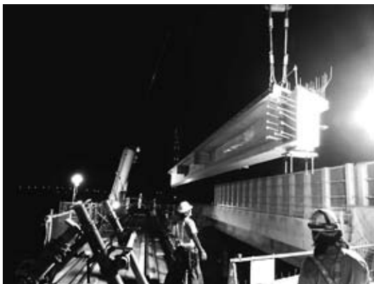
図-5 主桁架設状況
