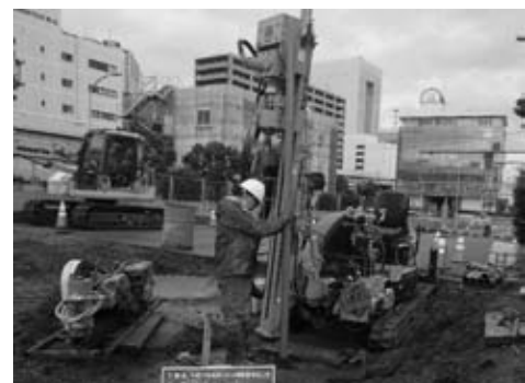
図-5 ボーリング施工状況
