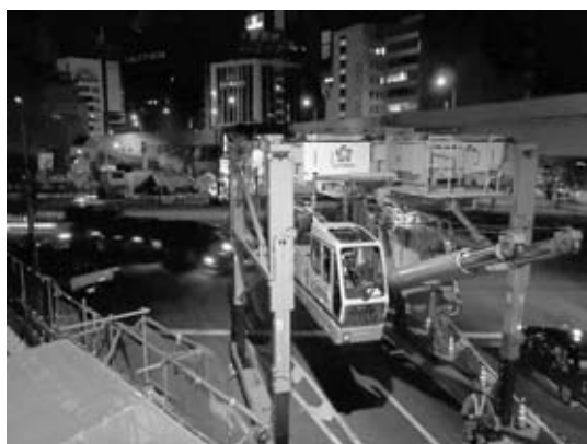
図-3 リフターによるクレーン組立状況
