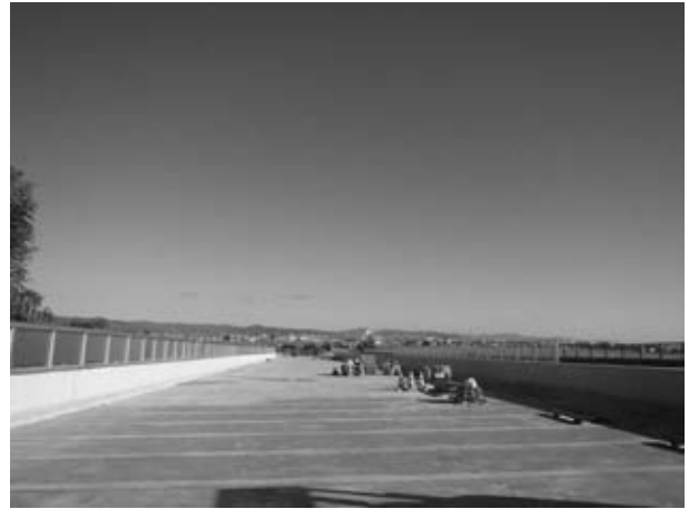
図-8 壁高欄施工完了（起点方より）
