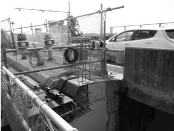
図-2 レーザースキャナー設置状況
