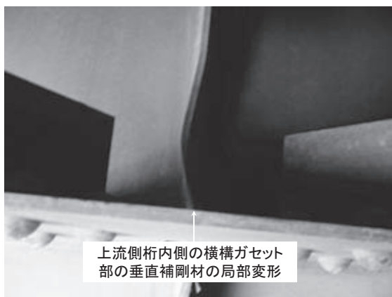
図-3 垂直補剛材の変形
