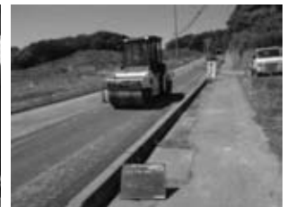
図-7 攪拌後転圧
