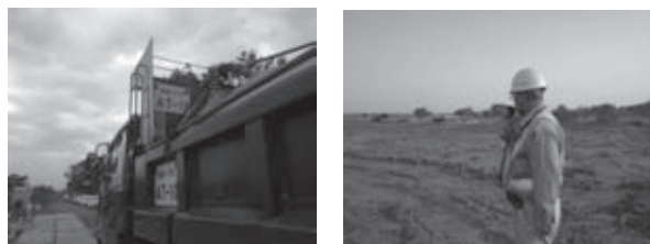
図-3 ダンププレートの設置及び構内誘導状況
