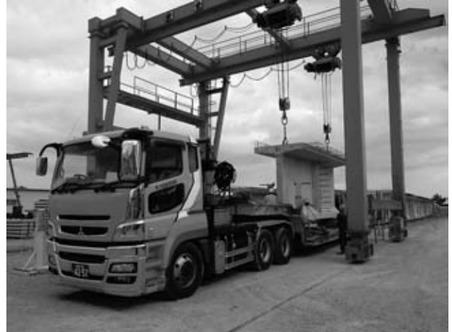
図-3 主桁出荷状況
