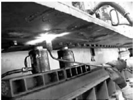
図-8 主桁下フランジ下面からの加熱矯正
