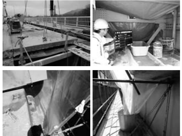
図-8 濁水採取状況（床版・地覆）
