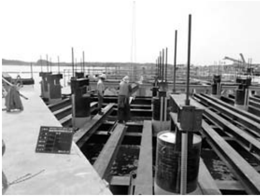
図-2 吊り支保工組立
