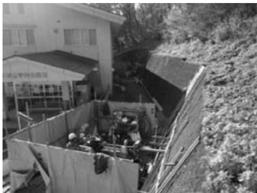
図-3 作業箇所全景
