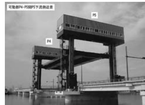
図-4 可動橋部（P4-P5）完成写真
