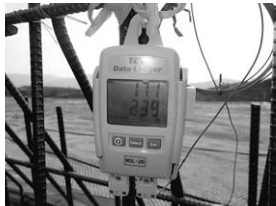
図-6 データロガーでの測定状況
