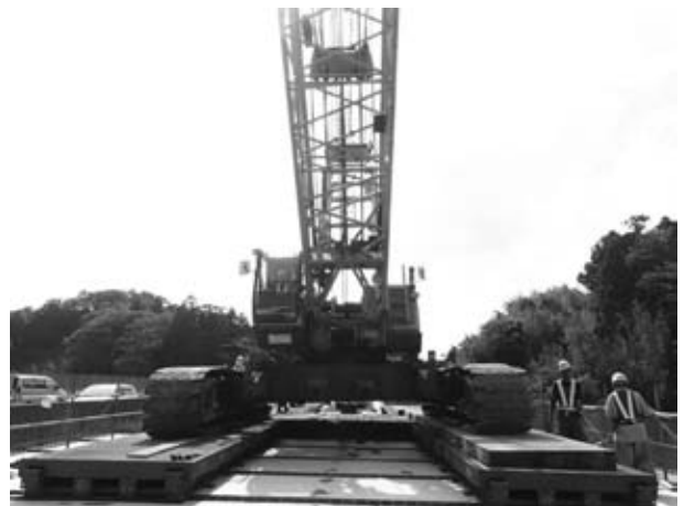
図-4 床版上補強状況(2)
