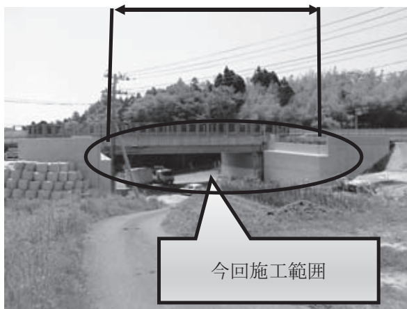
図-1 施工前全景
