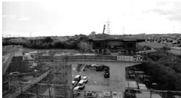
図-14 旋回横取り完了
