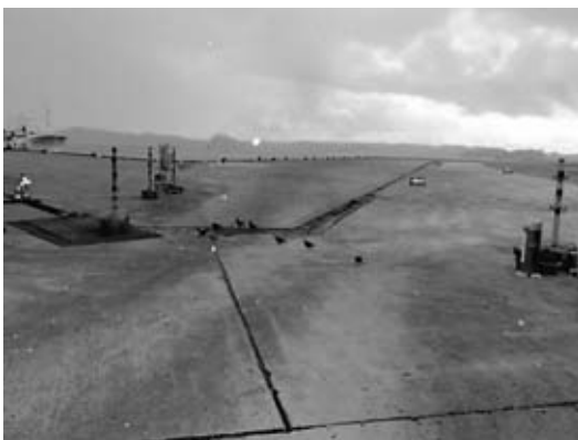
図-1 施工前全景
