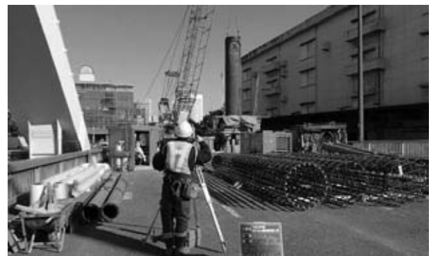
図-12 ケーシング鉛直度確認
