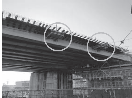
図-3 緊張、グラウト用足場組立
