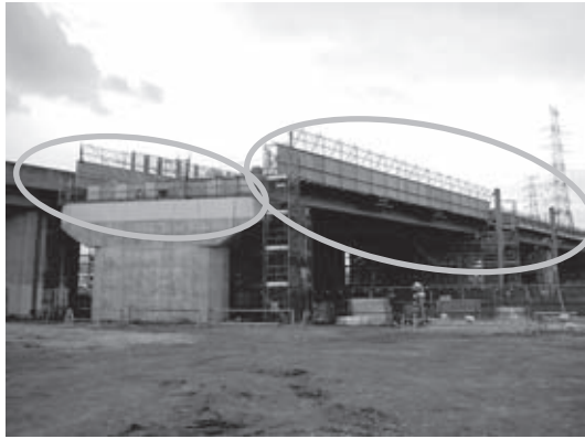
図-8 線路上の防護工
