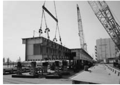
図-3 特殊天秤による鋼桁の架設(橋軸方向)
