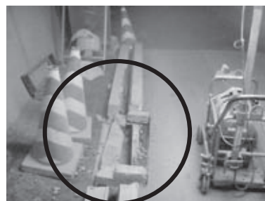
図-2 側溝の沈下及び転倒例
