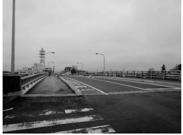
図-7 完成（起点方より）
