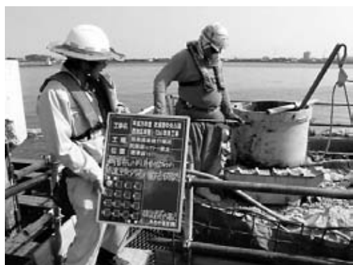
図-13 鋼管外側ケレン (高速空気タガネ使用)
