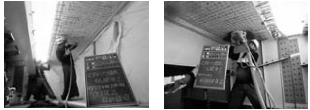
図-6 床版下面補強モルタル撤去工
