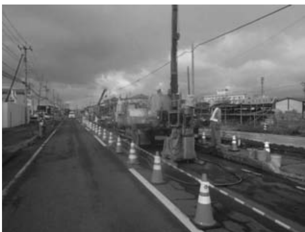
図-1 路線補足薬液注入状況
