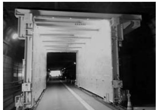
図-2 坑内プロテクターの視認性向上状況
