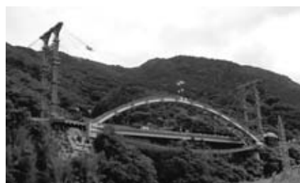
図-5 上弦材架設完了状況
