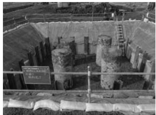
図-5 法面の浸食・崩壊防止対策写真
