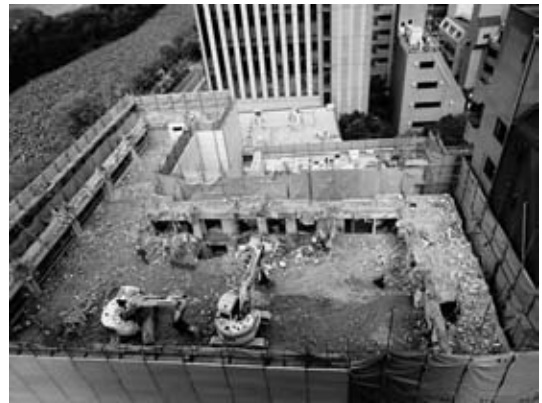
図-1 階上解体状況
