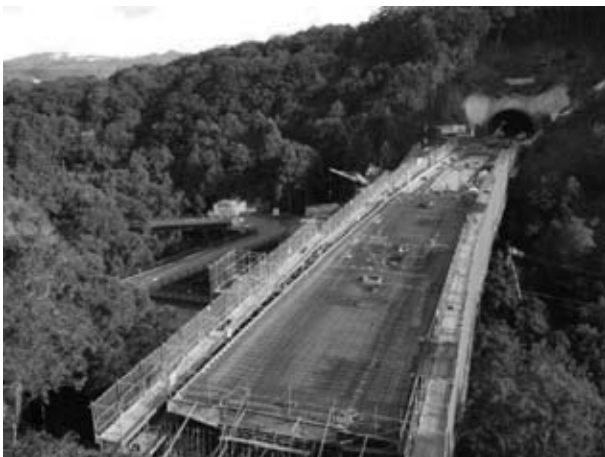
図-1 終点側より起点側を望む
