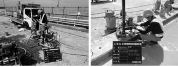
図-4 吊孔削孔（床版・地覆）
