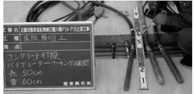
図-6 バイブレーター挿入深さマーキング
