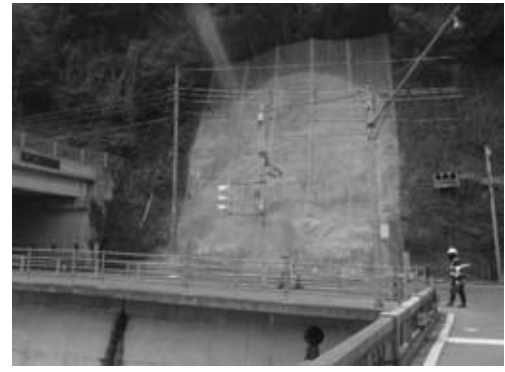
図-4 施工完了全景
