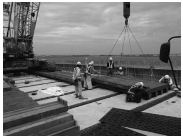
図-3 床版上補強状況(1)
