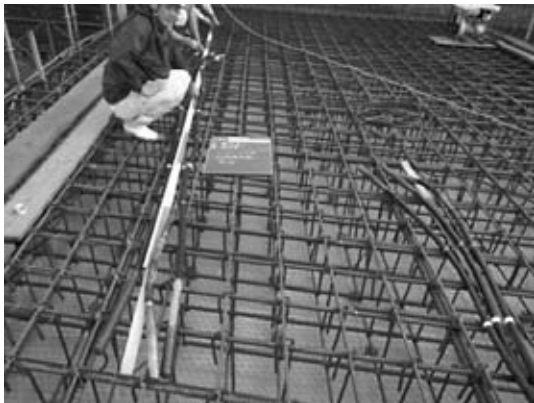
図-3 高周波バイブレータ
