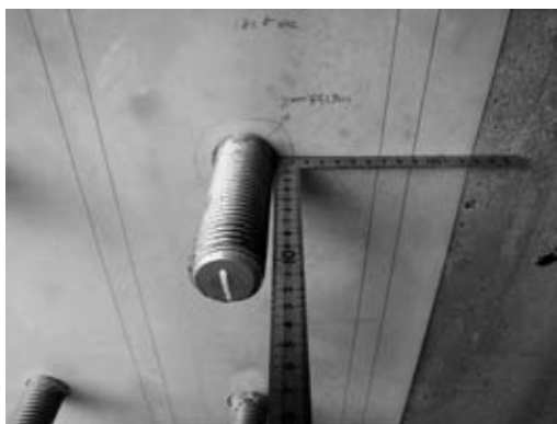
図-6 傾斜アンカーの例
