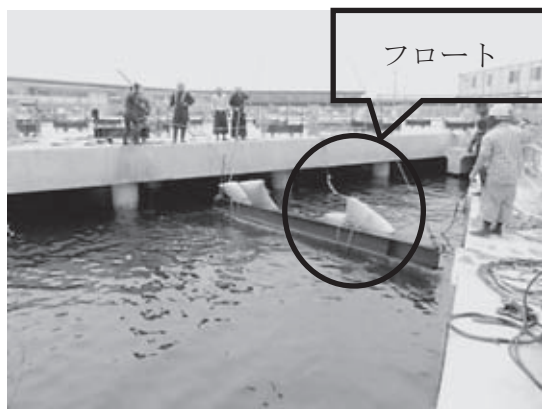
図-3 枕梁解体状況
