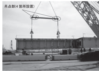
図-4 特殊天秤による鋼桁の架設(橋軸直角方向)
