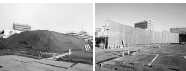
図-4 飛砂防止対策状況
