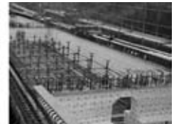
図-5 1リフト養生
