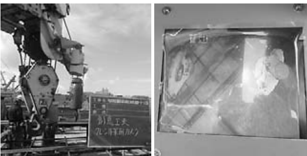
図-4 クレーン用カメラ（陸上）
