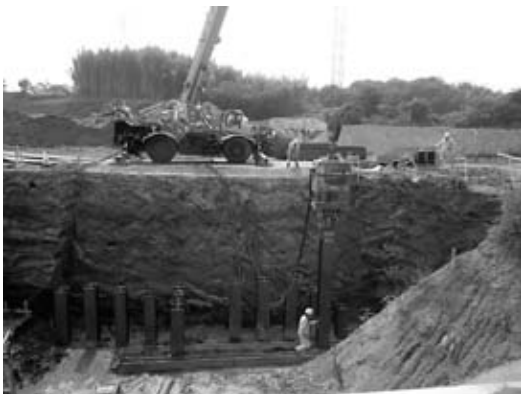
図-3 H鋼打設状況
