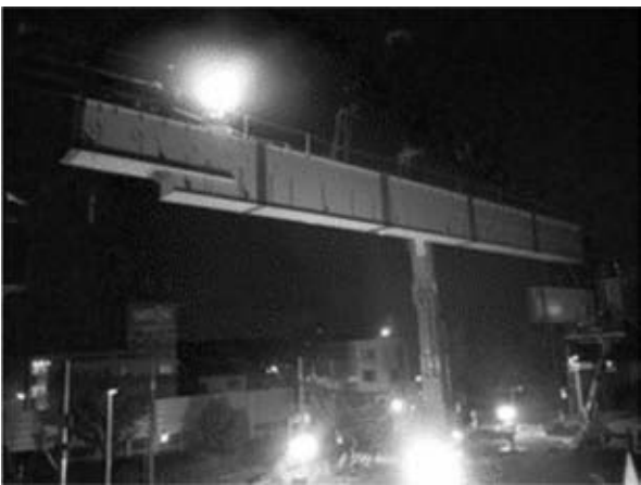
図-9 大ブロック架設状況
