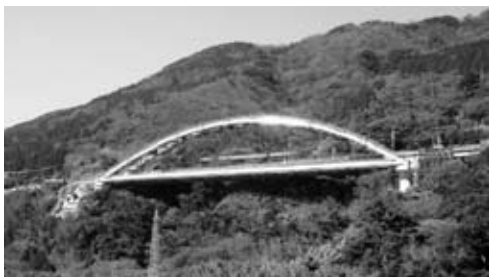
図-1 比丘尼谷橋全景（工事完成時）
