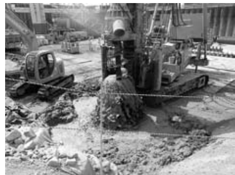
図-6 被圧地下水噴出状況
