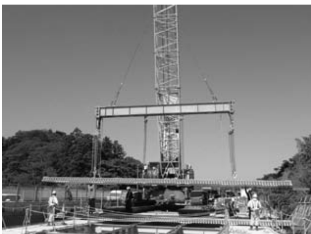
図-5 プレキャスト部材架設状況
