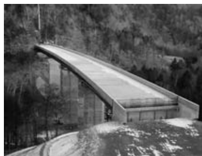
図-2 床版完成写真
