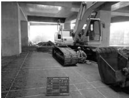
図-4 試験施工（平板载荷試験状況）
