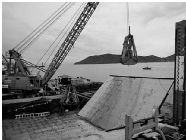
図-5 使用状況（土運船一起重機船間）
