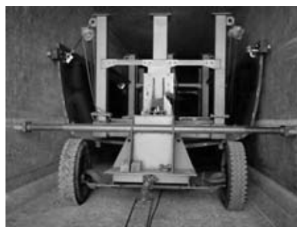
図-5 インバート材搬送状況
