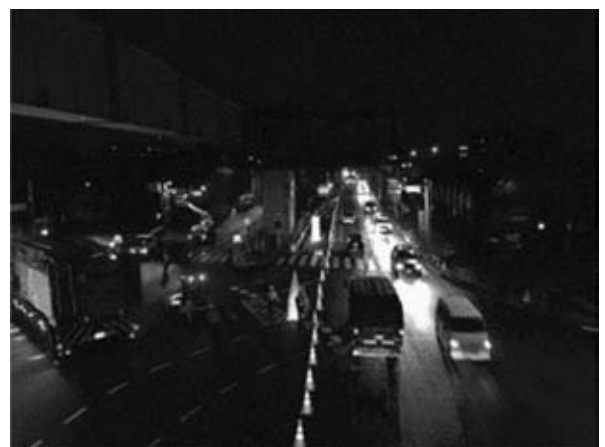
図-11 対面通行規制状況
