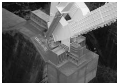
図-6 支柱等基部補強完了
