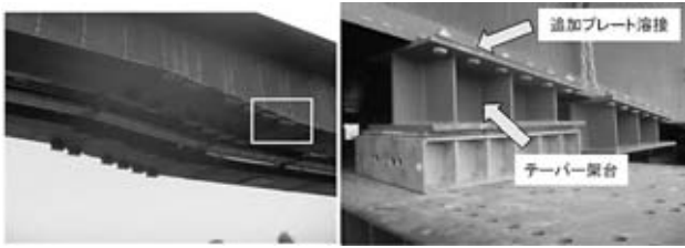
図-6 テーパー架台設置状況
