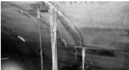
図-1 漏水の凍結状況
