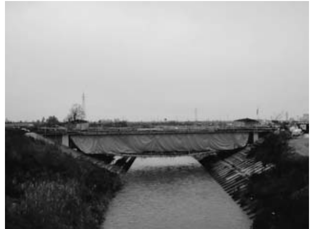
図-8 床版養生状況
