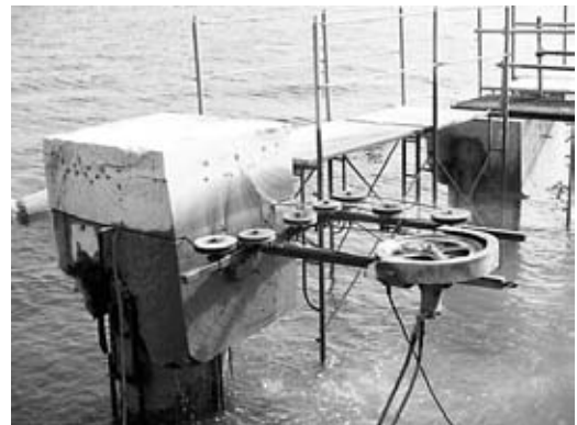
図-6 杭頭上部切断撤去状況
