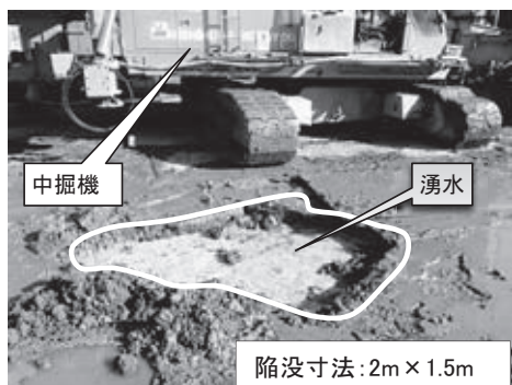
図-9 施工基盤陥没状況
