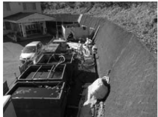
図-6 資機材設置状況
