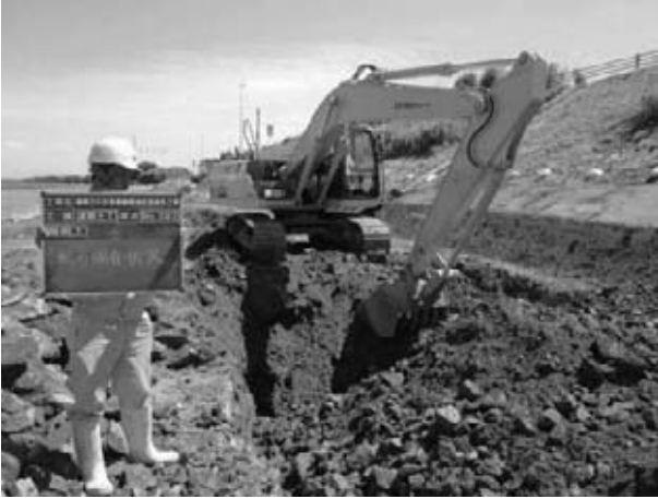
図-1 支障物除去状況
