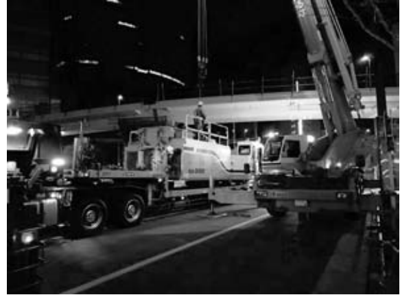
図-10 大型クレーン解体状況
