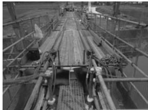
図-6 前方滑車設置状況
