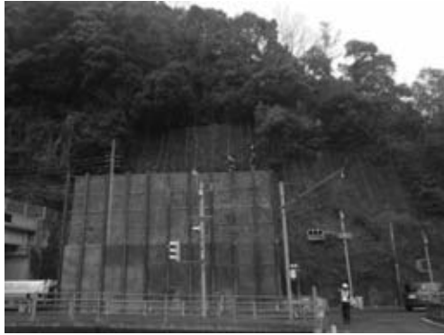
図-3 防護柵設置後伐採状況
