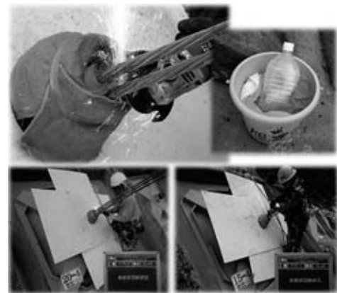
図-12 鋼線切断時の熱、火花対策
