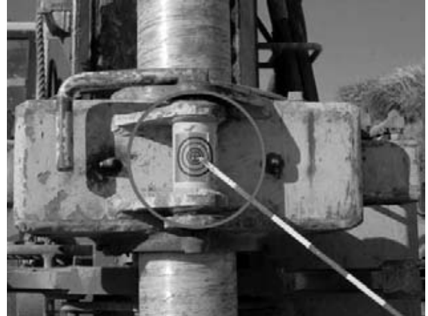
図-2 改良杭施工中の位置確認測量状況
