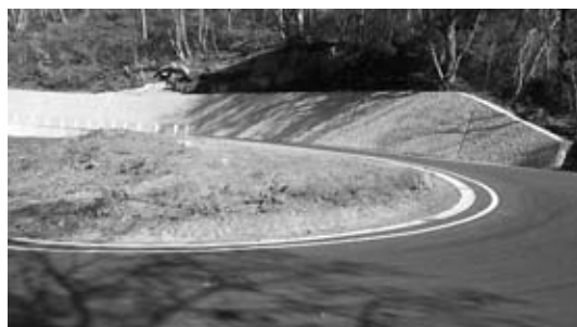
図-6 現場完成写真
