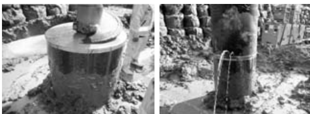
図-8 被圧地下水溢れ出し状況
