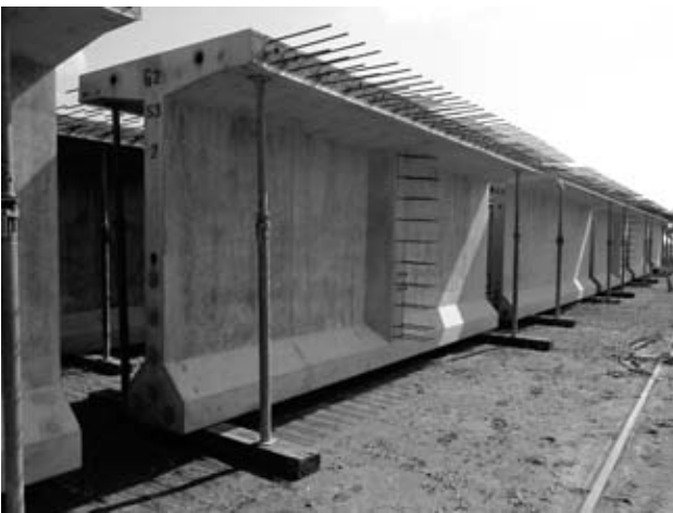
図-2 主桁仮置き状況
