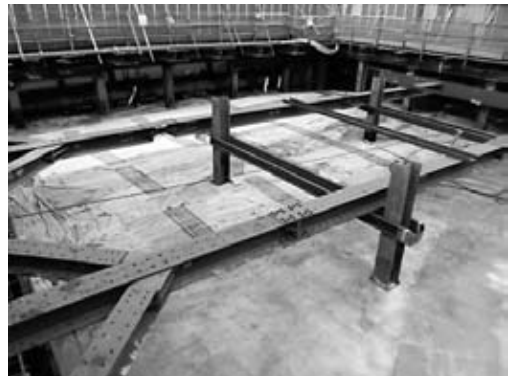
図-1 コンクリート養生状況（例）
