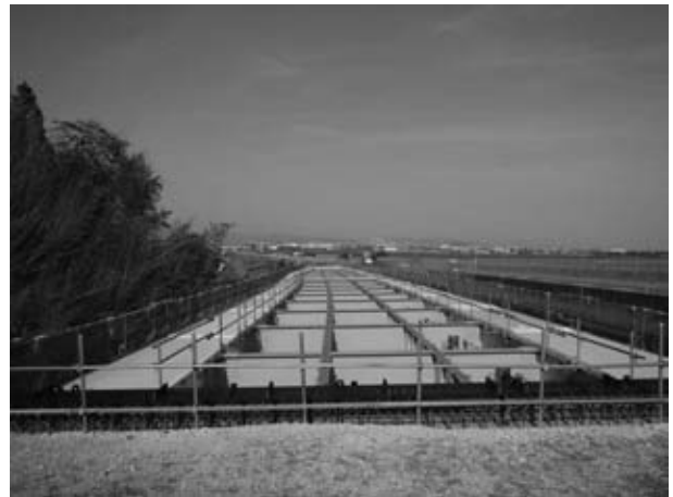
図-1 施工前全景
