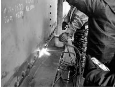
図-7 主桁ウェブ下端の加熱矯正
