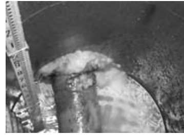
図-3 既設No.1到達状況
