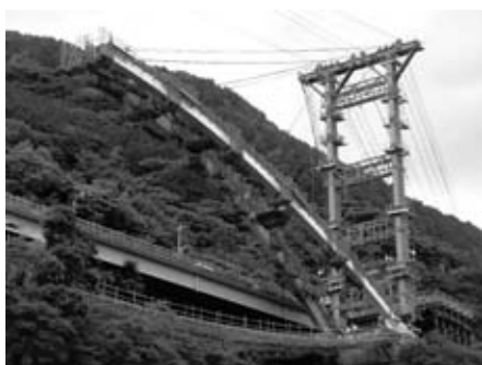
図-3 上弦材架設状況
