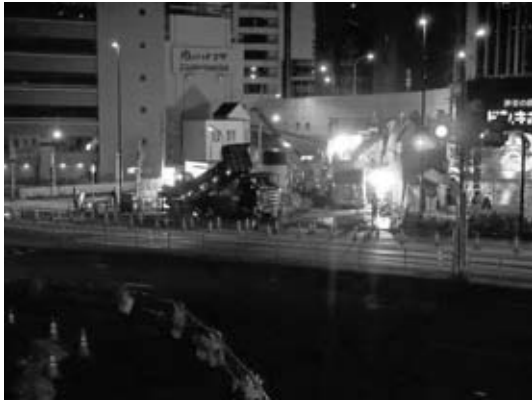
図-6 銀座側橋脚基礎施工状況
