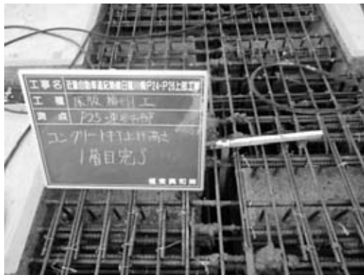
図-4 打ち上げ高さの管理
