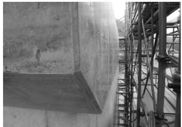
図-6 脱型後のコンクリート
