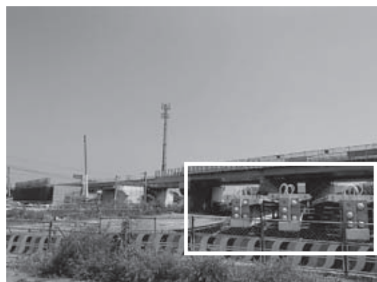
図-2 主桁仮置状況
