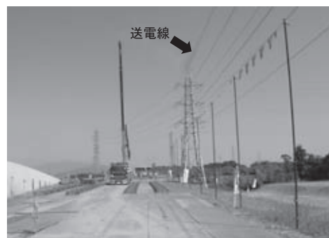
図-2 送出しヤード全景
