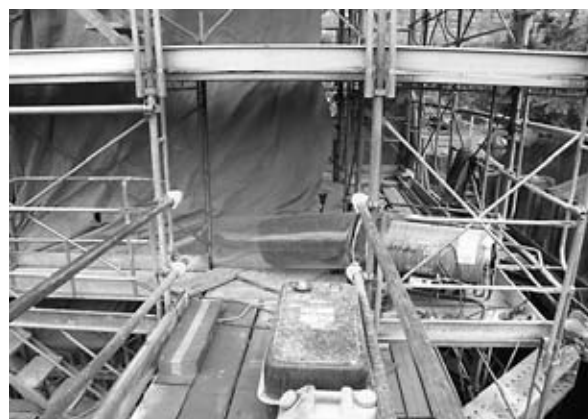
図-9 ジェットヒーターによる給熱養生
