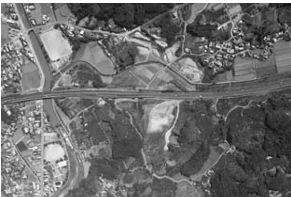
図-1 着工前全景
