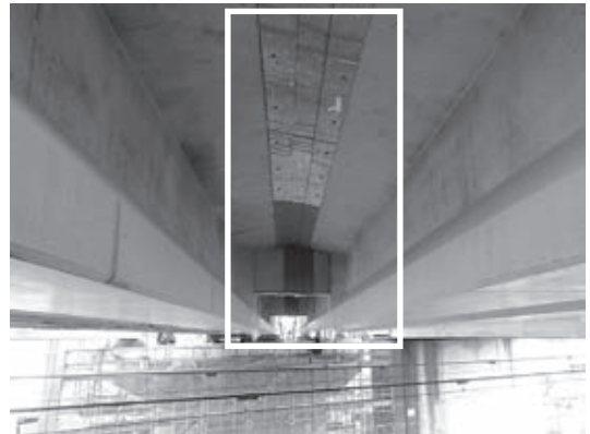
図-7 塩ビ板型枠組立状況
