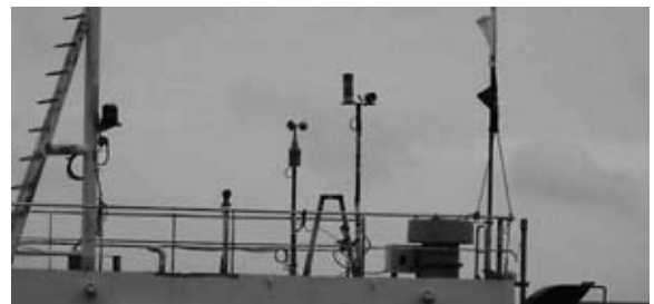
図-7 風速計設置
