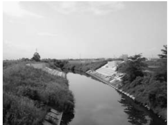
図-1 施工前状況
