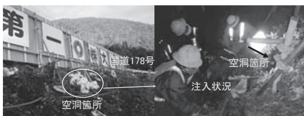
図-4 空洞処理状況
