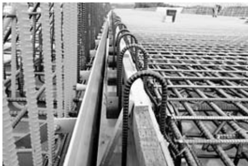
図-2 上下線の隙間（左側が合成床版）
