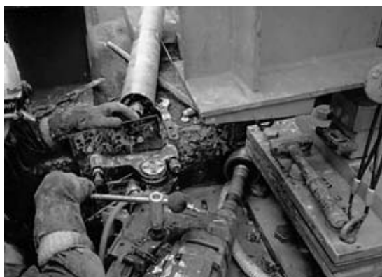
図-2 支承台座ハツリ作業(コア削孔)
