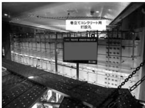
図-5 巻立てコンクリート用打設孔
