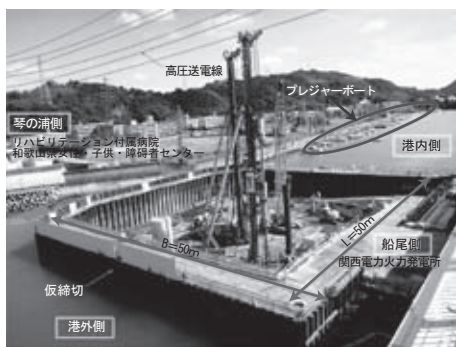
図-5 鋼管杭中掘施工状況
