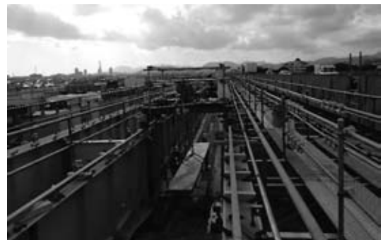
図-5 桁間吊り設備
