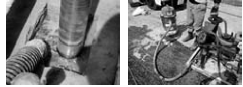
図-7 濁水採取状況（吊孔削孔）
