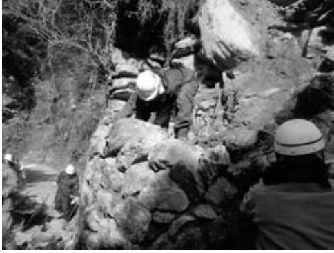
図-3 石積み状況
