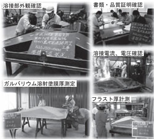
図-10 鋼製受圧板工場検査
