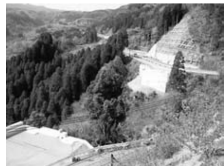
図-2 急峻な斜面を有する現場状況
