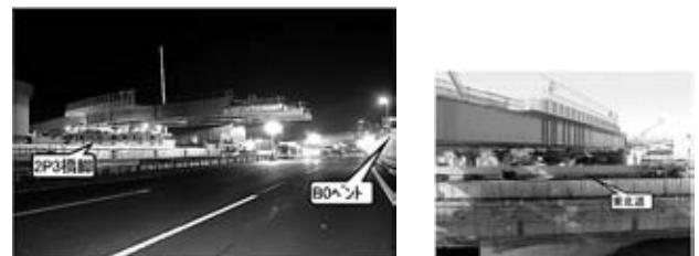
図-11 送り出し状況と完了風景
