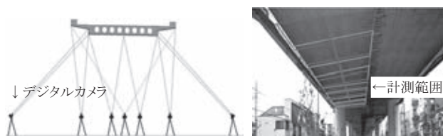
図-3 デジタルカメラ計測のひび割れ調査
