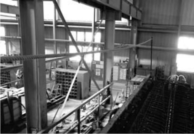
図-1 親綱、手すり設置状況
