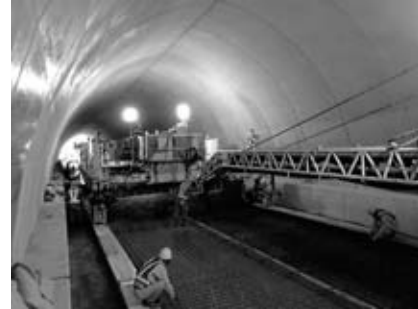
図-5 SPでの施工状況
