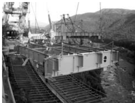
図-6 床組み部材架設状況
