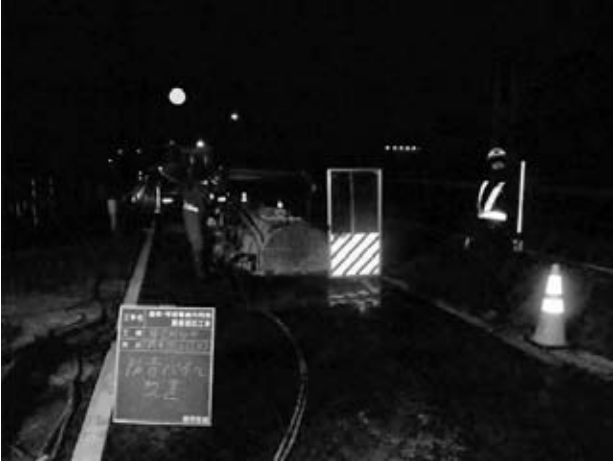
図-2 防音パネル
