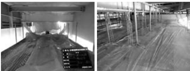
図-10 吊足場シート養生状況(中段・下段)
