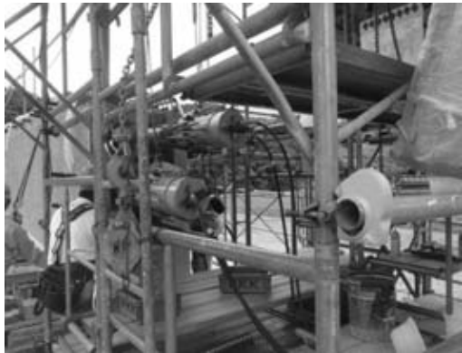
図-4 緊張装置2組による緊張状況
