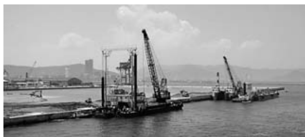
図-2 起重機船揚土状況
