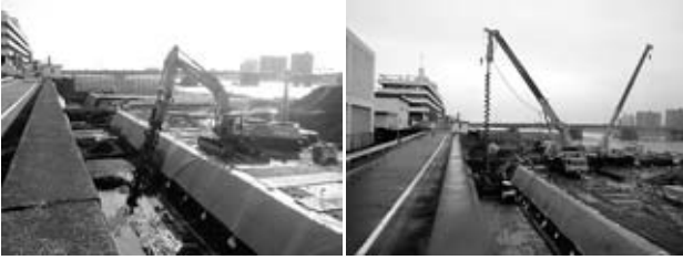
図-3 パワーブレンダー工法 (左) ロックスカット工法 (右)
