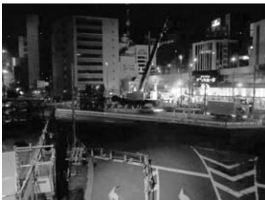
図-7 銀座側桁地組状況
