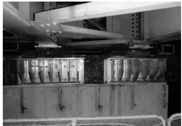
図-8 ブラケット設置状況
