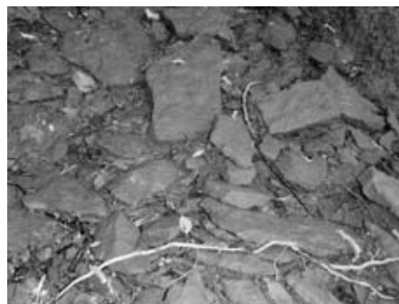
図-4 剥離落下した岩盤
