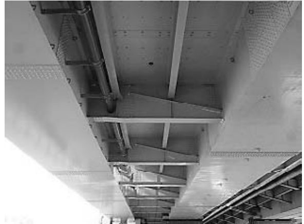
図-7 鋼板接着工法
