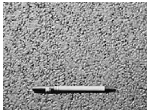
図-6 SMA の舗装表面
