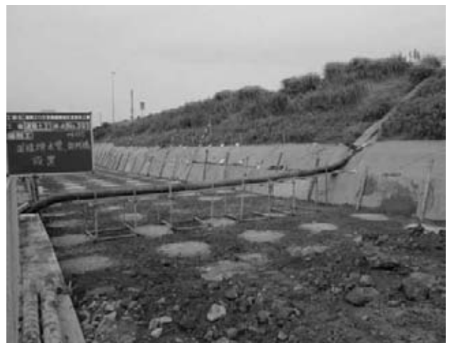
図-3 供用道路排水状況（仮設橋と波状管）
