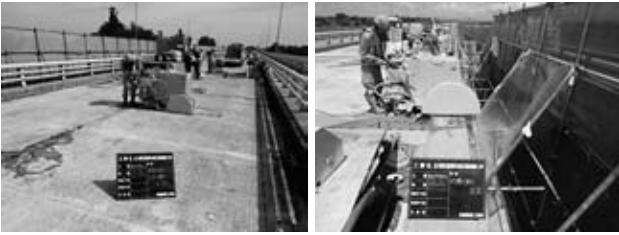
図-5 床版1次切断（床版・地覆）
