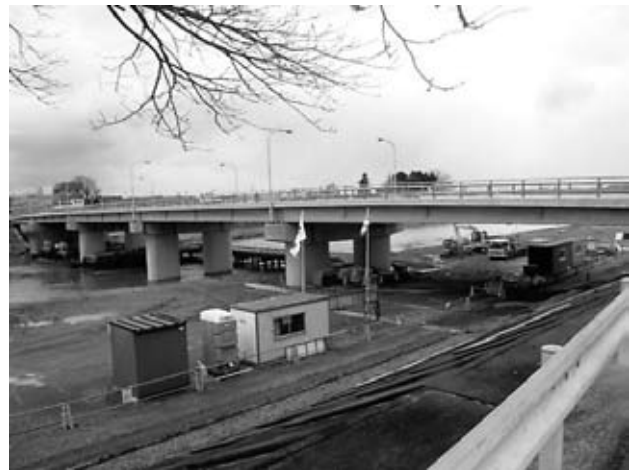
図-8 完成（上流方より）
