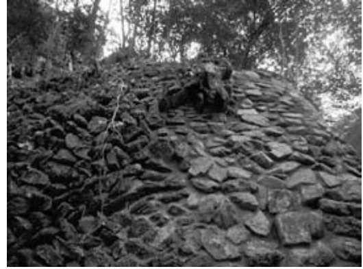
図-4 石積み完了
