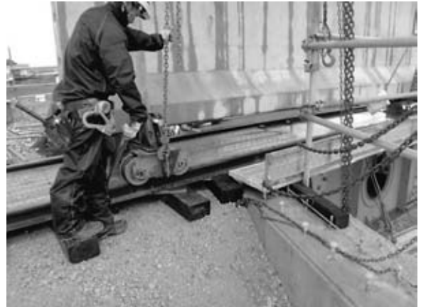
図-5 ガーダーとレールの接続部
