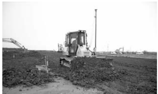
図-4 3D-MC 施工状況
