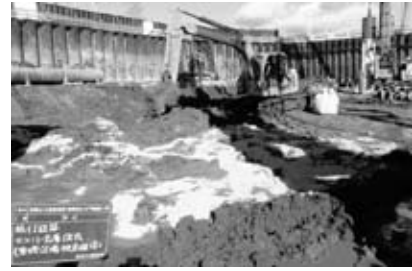
図-15 表層改良状況
