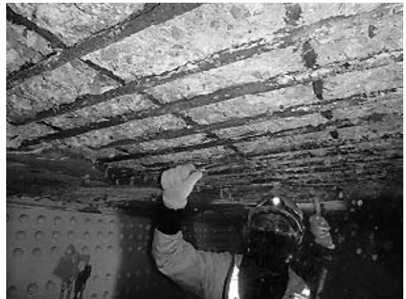
図-8 既設床版鉄筋の発錆状況
