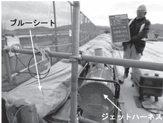
図-4 保温養生状況
