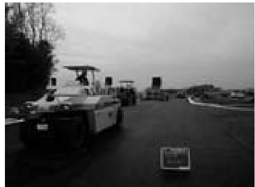
図-5 SMA 舗装施工状況
