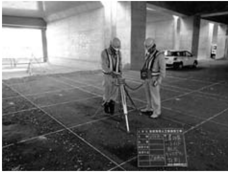
図-3 試験施工（キャスポルによる測定）
