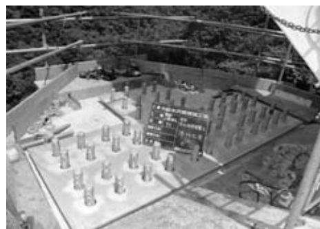
図-5 補強材(プレート)設置完了
