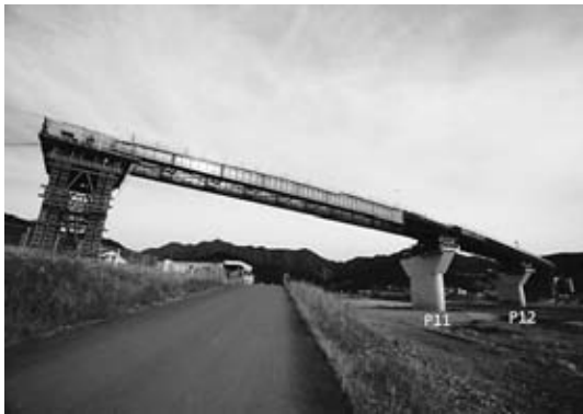
図-10 送り出し架設状況
