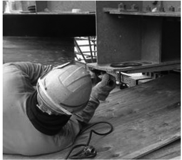
図-8 ソールプレート撤去状況
