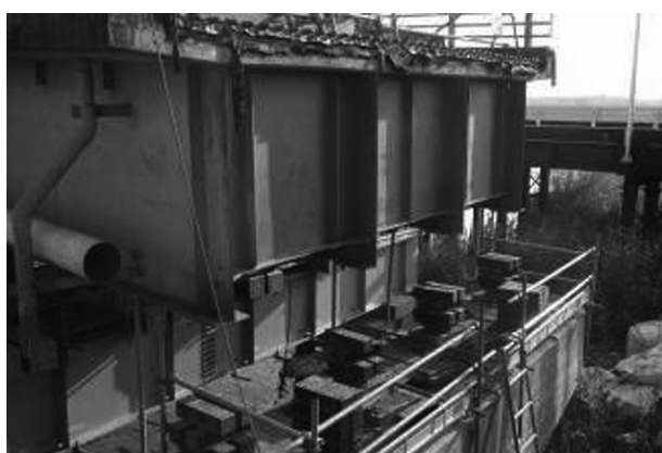
図-10 桁扛上後 (P3 橋脚)
