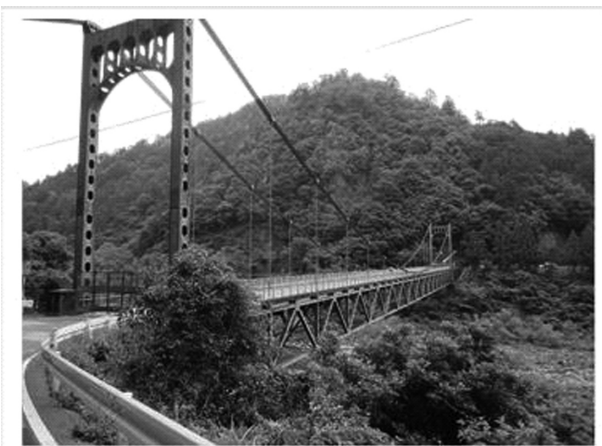
図-1 原田橋（補修前）
