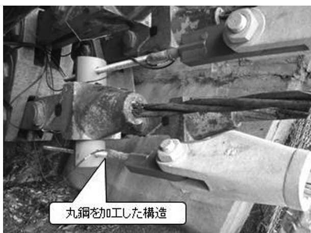
図-5 ロッド定着構造
