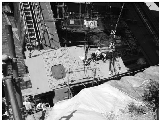
図-9 部材据付状況(方杖基部)
