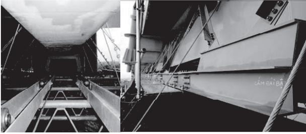
図-9 TBトラス設置状況
