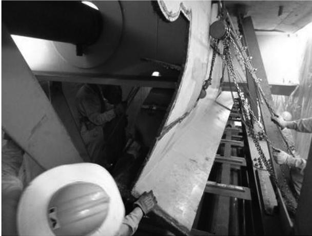
図-10 桁切断状況
