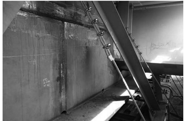
図-12 新設部材の取付け・溶接状況
