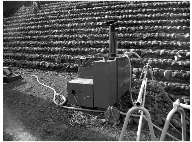
図-11 練混ぜ水加温設備
