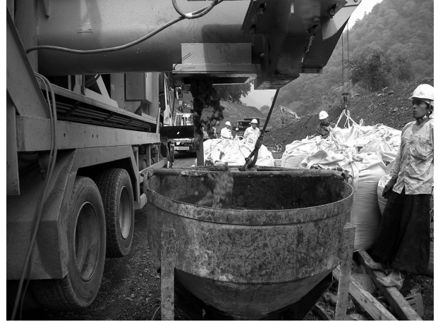
図-7 コンクリートホッパー改良
