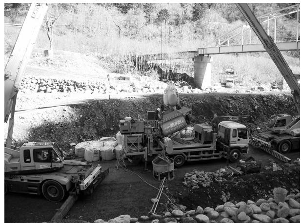
図-8 クレーン2台による施工状況
