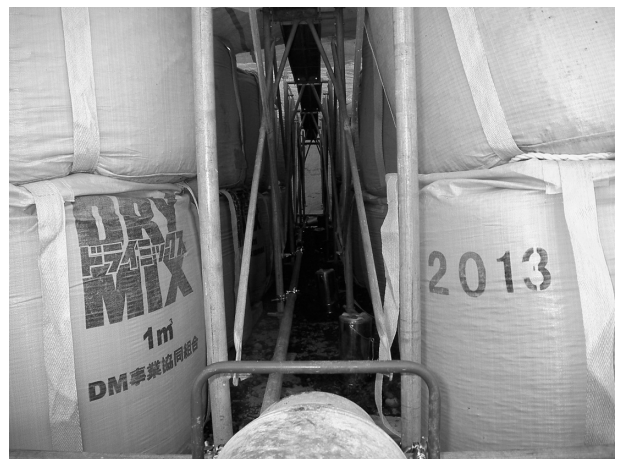
図-13 DM 製品養生施設内状況
