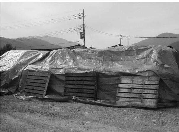
図-10 DM 製品養生状況
