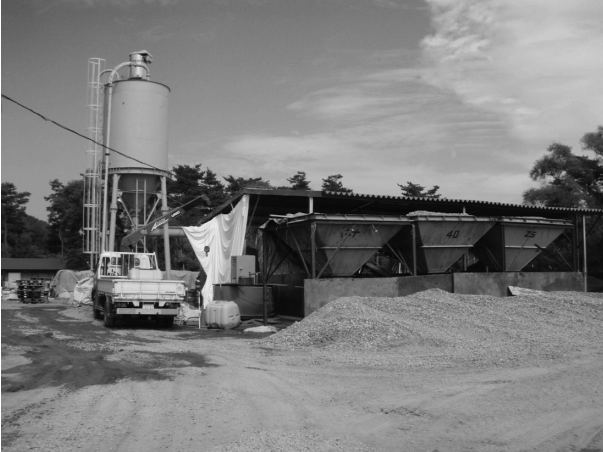
図-6 仮設DM工場
