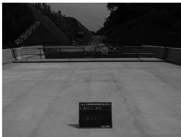
図-5 完成した床版
