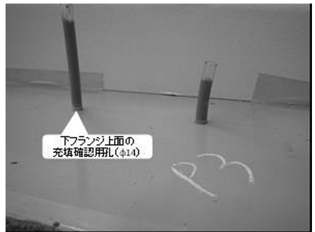
図-7 空気孔による充填状況の確認
