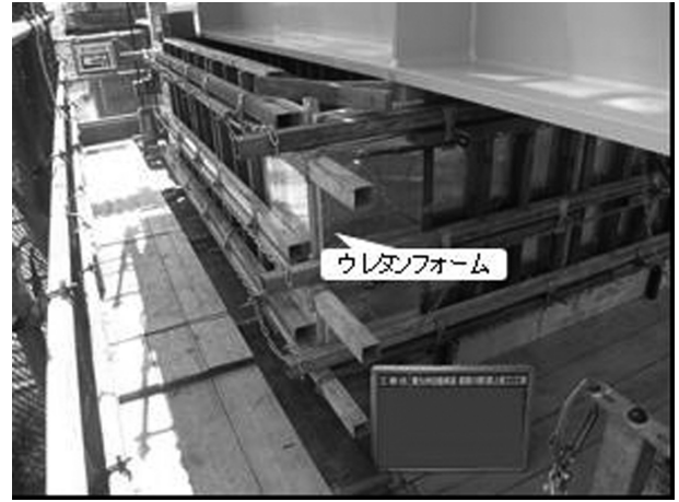
図-3 養生材を貼り付けた型枠組立
