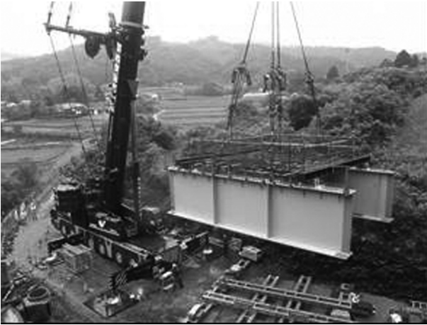
図-1 剛結部のブロック化による架設
