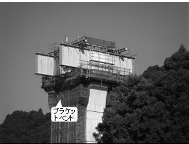
図-2 ブラケットベントによる仮固定
