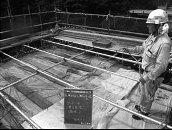
図-8 散水養生の状況
