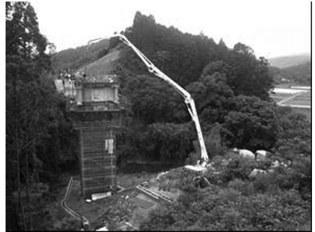
図-5 剛結部コンクリートの打ち込み状況
