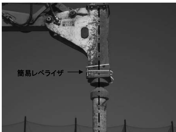
図-9 簡易レベライザ装着後の鉛直補正
