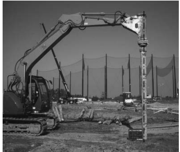
図-4 木杭とブレーカの鉛直性が確保された状態
