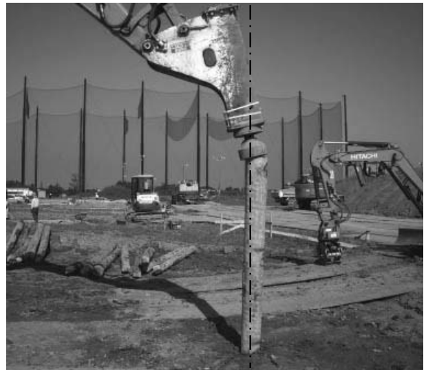
図-5 鉛直性が確保されていない状態
