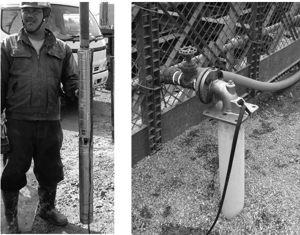
図-8 深井戸用水中ポンプ (左)、減圧井戸完了 (右)
