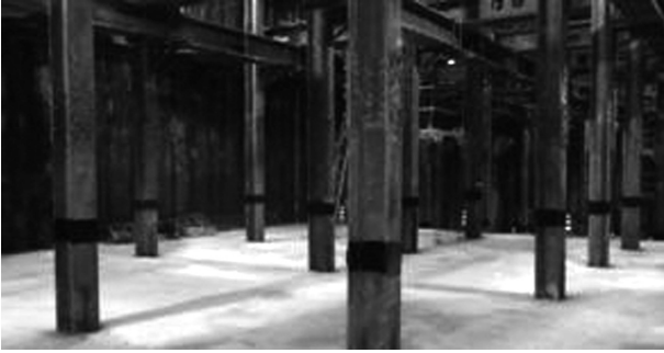
図-5 中間杭スパンシール設置完了
