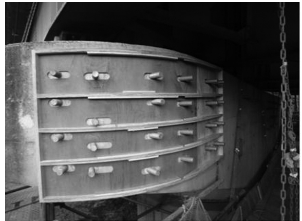
図-10 曲線ブラケットの設置確認
