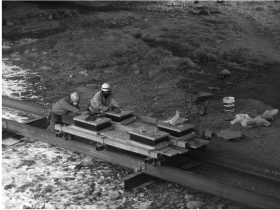
図-8 軌条設備を使った運搬
