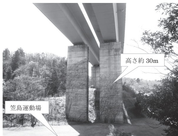
図-1 笠島橋 橋脚
