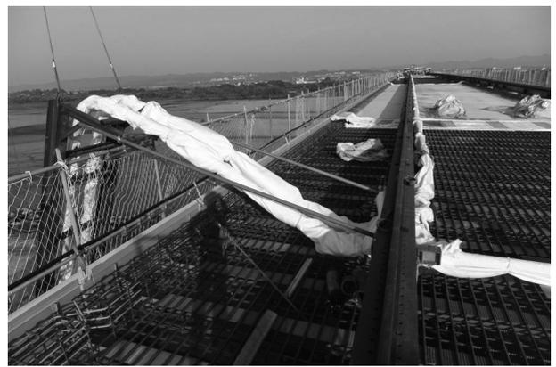
図-8 配管養生状況
