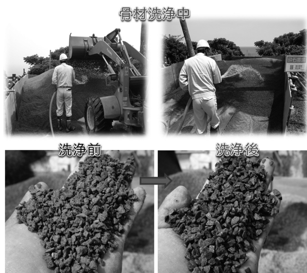
図-7 骨材洗浄状況
