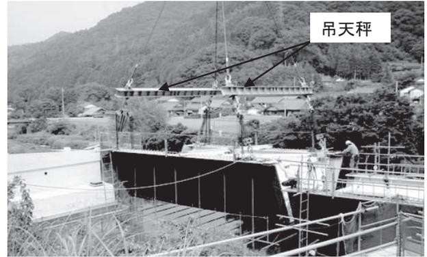
図-8 主桁クレーン架設
