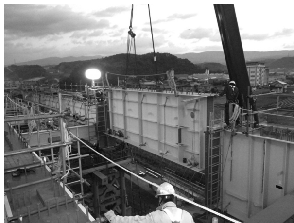
図-4 落とし込み架設状況
