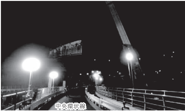
図-6 既設桁撤去(夜間全面通行止め)
