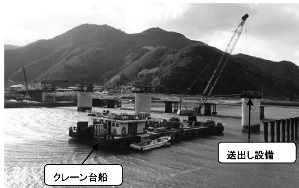
図-4 クレーン台船使用状況
