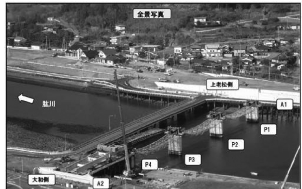
図-1 送出し架設全景
