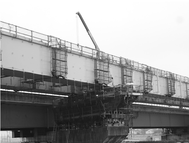
図-9 小型クレーン装置（P1支点上）
