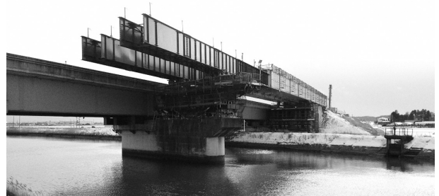
図-2 鋼桁の送出し状況
