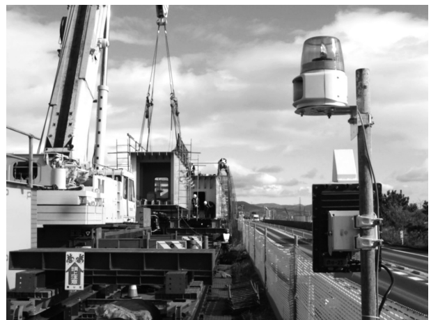
図-4 クレーン作業警報監視システム
