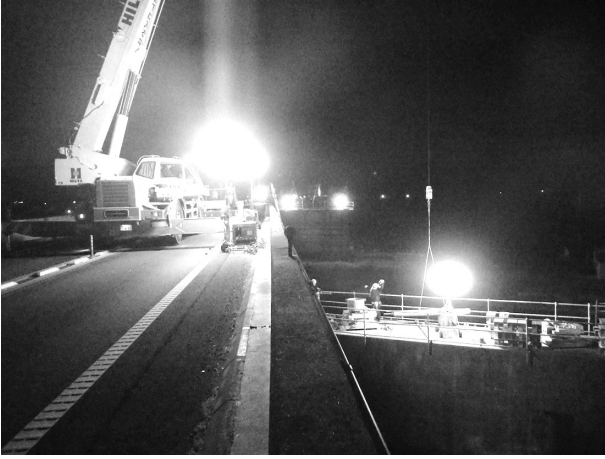
図-8 三陸道夜間通行止めによる作業
