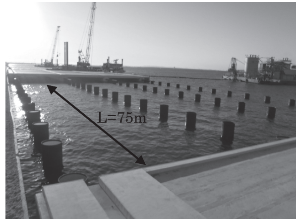
図-3 着工前写真
