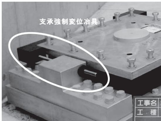
図-4 支承強制変位治具 設置状況
