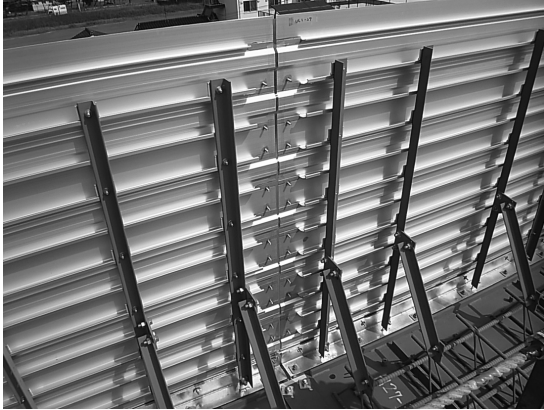
図-2 方杖材配置状況
