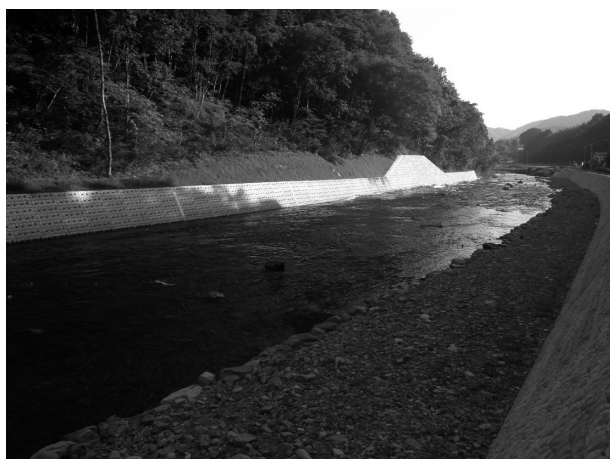
図-3 右岸盛土写真
