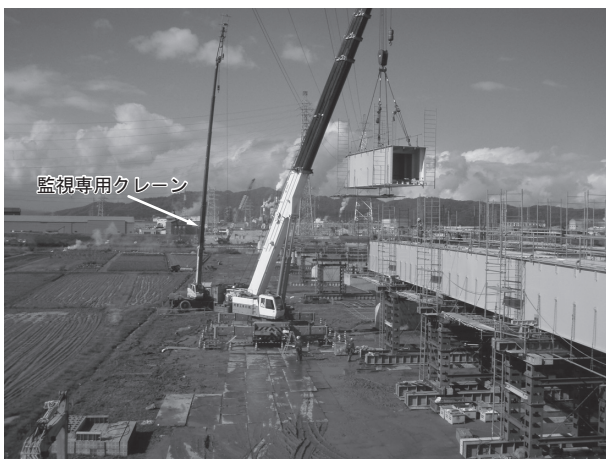
図-2 架設状況写真
