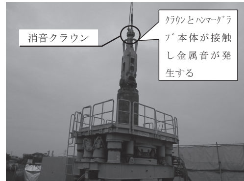
図-5 ハンマーグラブによる掘削状況
