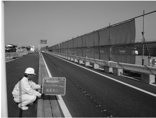
図-2 メッシュシート設置完了（南側）
