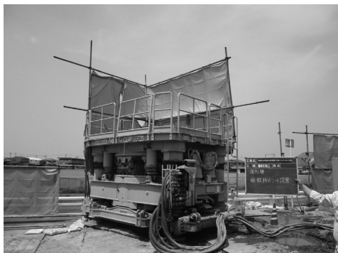
図-3 全周回掘削機 飛散防止ネット設置
