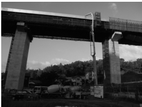
図-2 ポンプ車配置状況
