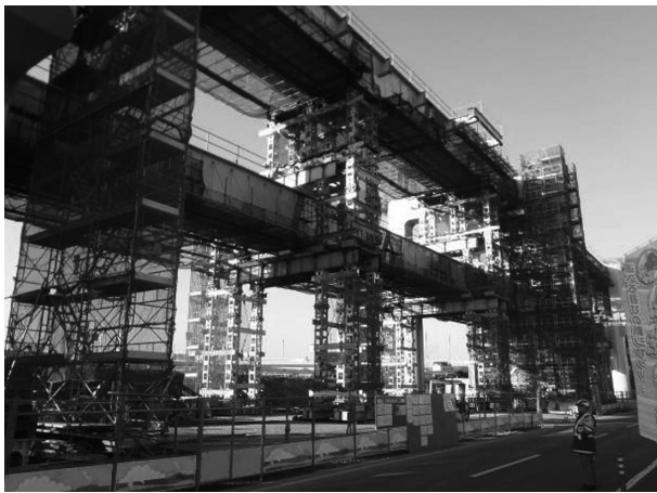
図-3 ベント設備設置状況
