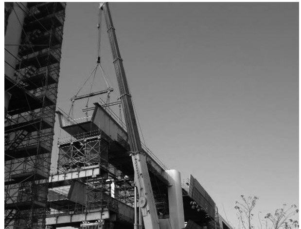
図-5 吊り天秤の使用状況
