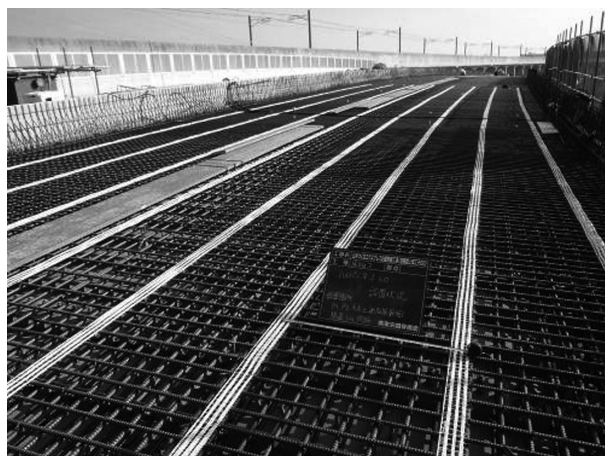
図-5 ひび割れ低減材の敷設状況
