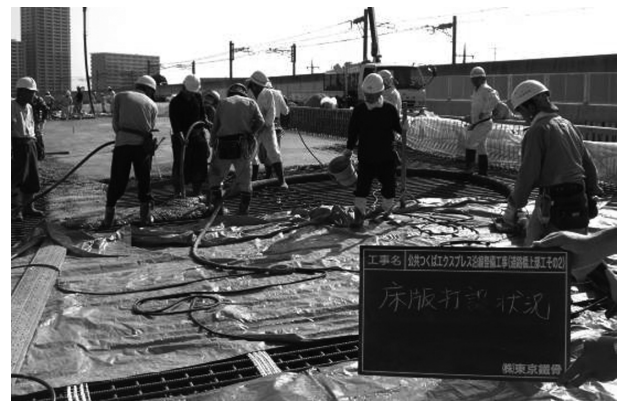
図-3 コンクリート打設状況
