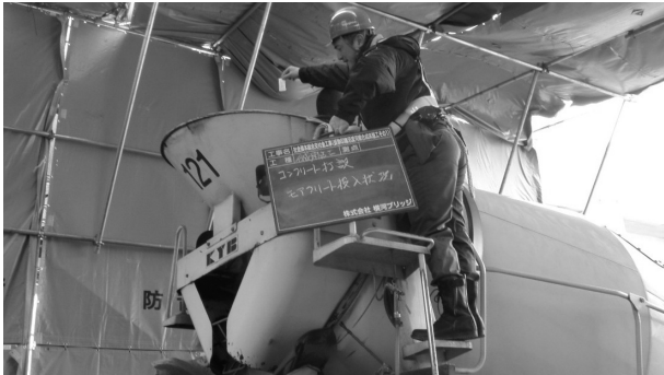
図-3 モアークリート投入状況
