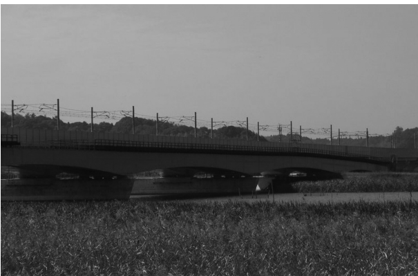
図-1 着工前全景（桁は架設済み）
