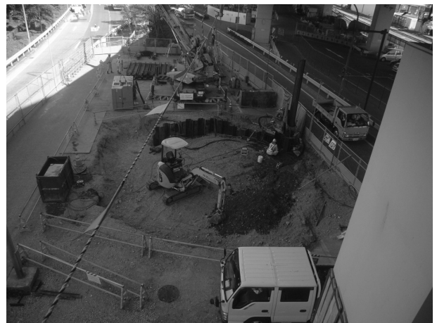
図-2 中央分離帯での施工状況
