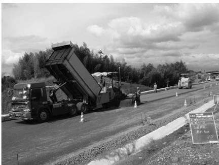
図-3 ベースペーパーによる施工状況（上層路盤工）
