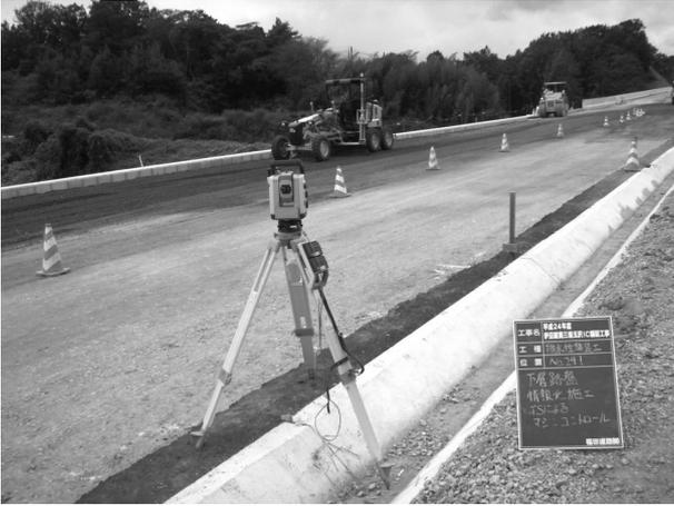
図-2 TSの設置状況（下層路盤工）
