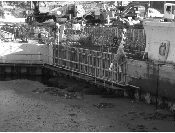
図-2 前面型枠組立状況
