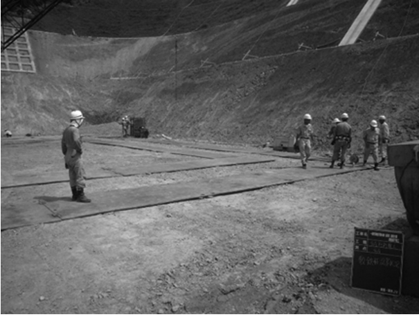
図-2 敷き鉄板養生状況
