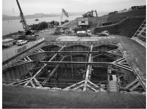
図-5 柱列杭完成全景
