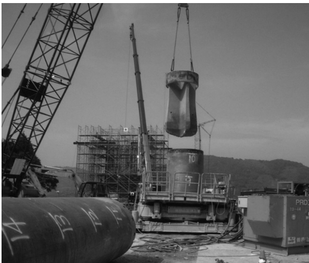
図-4 チゼルによる転石破碎状況
