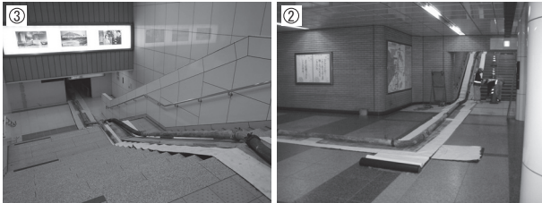
図-2 コンクリート打設中（1時30分～3時00）
