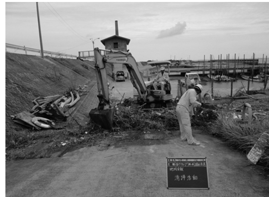
図-6 漁港内進入路塵芥撤去状況
