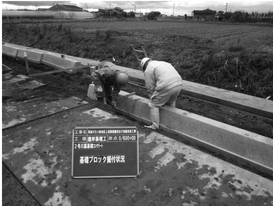
図-3 基礎ブロック据付状況 L=960m
