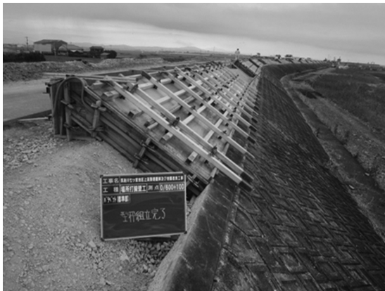
図-4 パラペット先行施工状況 L=380m
