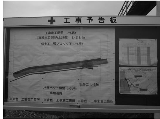
図-5 近接漁港内に『工事予告板』設置
