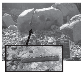
図-4 油圧割岩機による小割り
