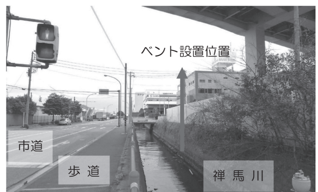
図-2 ベント設置位置と市道・禅馬川（施工前）
