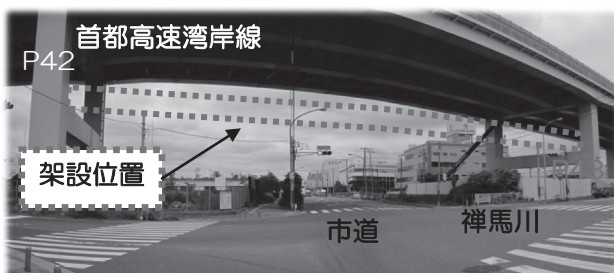
図-1 架設位置（施工前）
