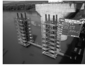
図-7 ベント足場
