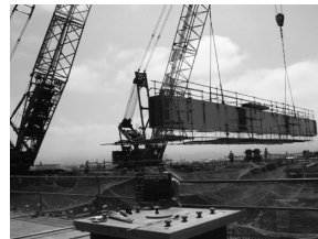
図-6 補剛桁相吊架設
