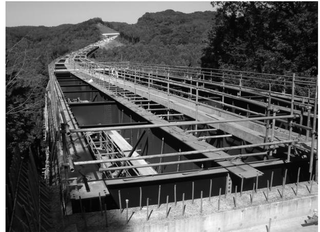
図-5 送し架設完了（起点側より）
