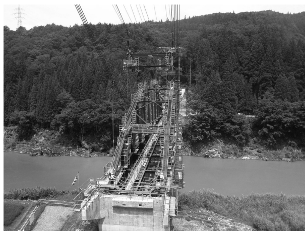
図-4 上弦材地組架設状況
