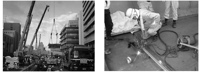
図-4 既設桁撤去状況
