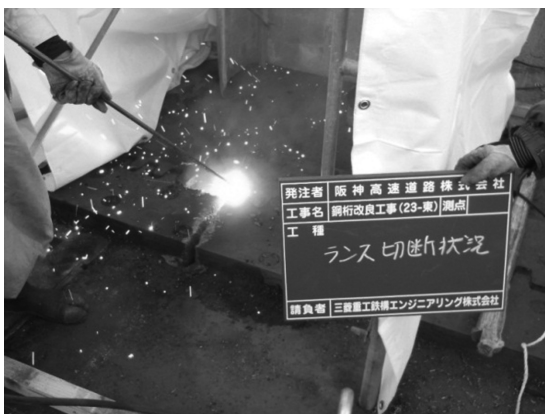
図-3 シャープランス切断状況
