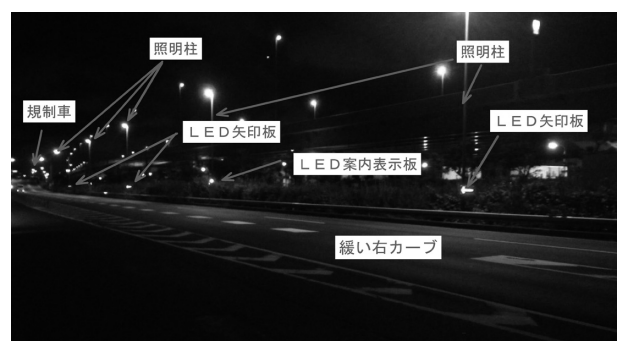
図-5 LED 矢印板・案内表示板の設置状況
