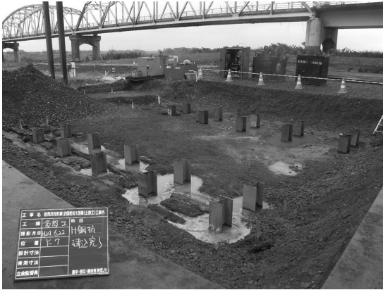
図-2 クレーンヤード杭基礎
