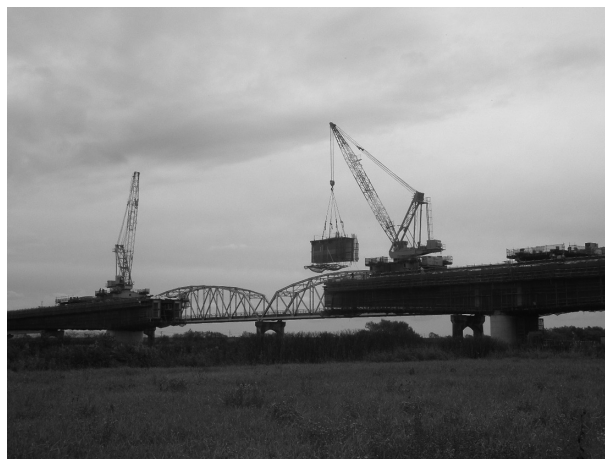
図-1 トラベラークレーン架設
