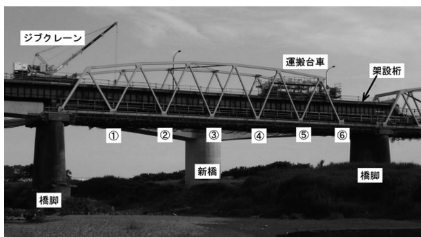
図-2 運搬台車上足場設備
