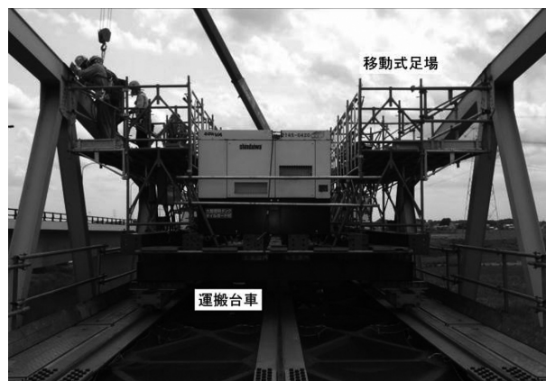
図-3 運搬台車上足場設備
