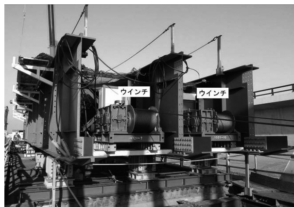
図-4 架設桁先端牽引設備
