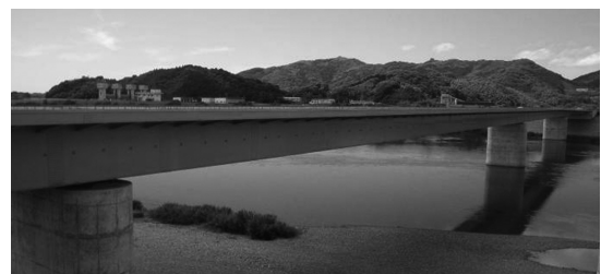
図-5 架設完了全景（始点側より）
