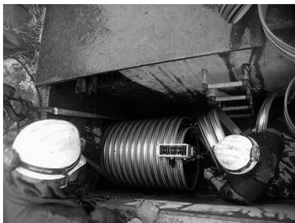
図-4 【SPR 工法】製管状況
