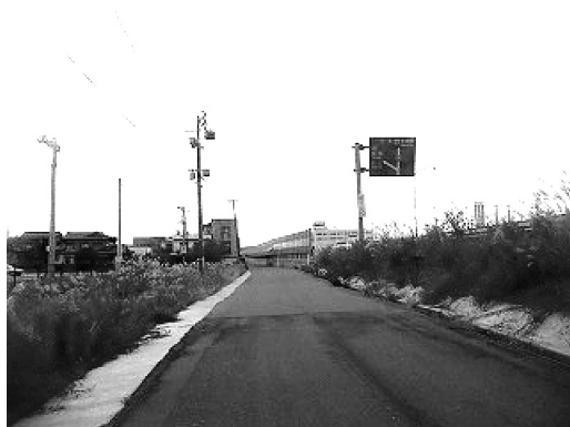
図-2 国道49号亀田バイパス側道
