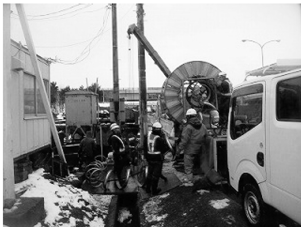
図-3 【SPR 工法】製管状況
