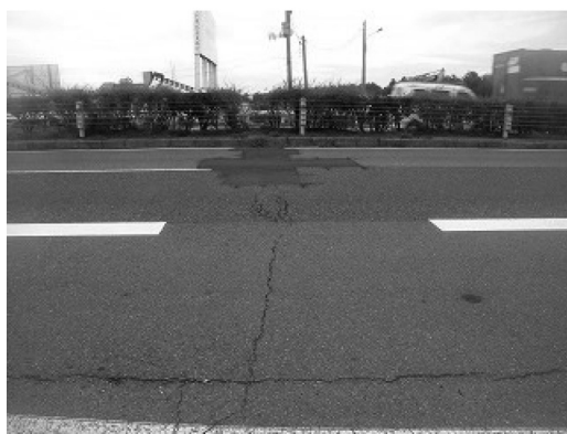
図-1 国道49号バイパス下り線
