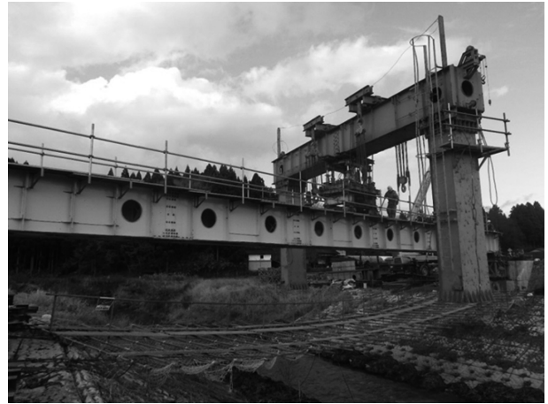
図-4 主桁横移動門構の縦移動
