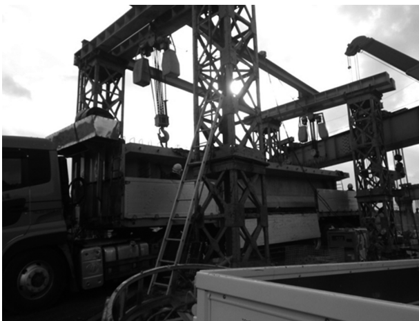
図-3 セグメント取降ろし門構
