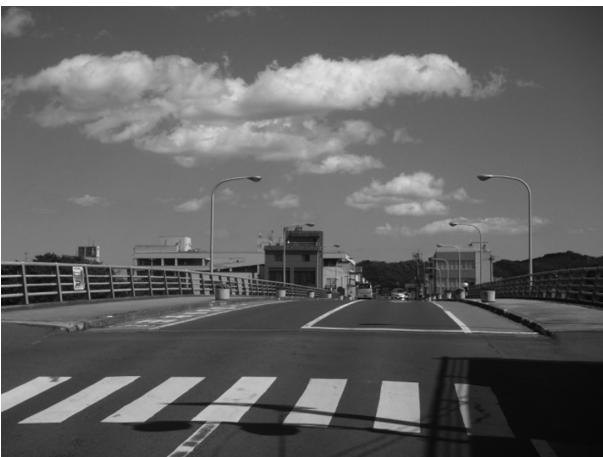
図-1 施工前全景
