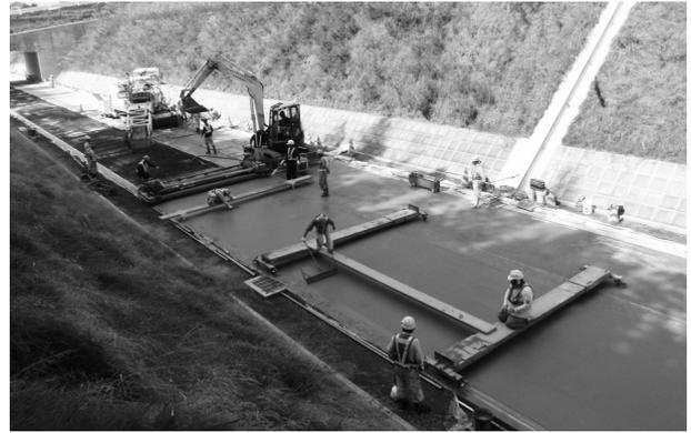
図-3 コンクリート舗装の施工状況
