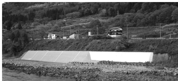
図-5 現場完成写真
