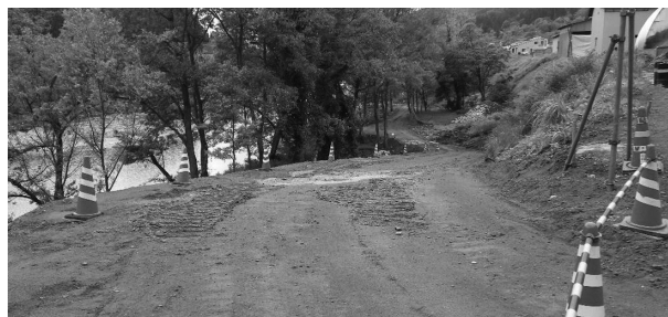
図-4 仮設道路状況写真
